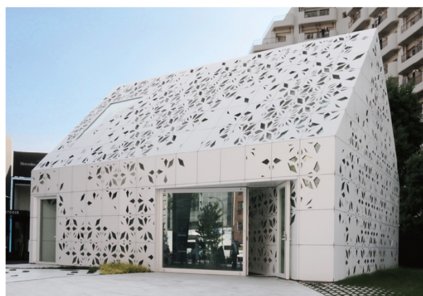
図 3. 都内某所展示施設
