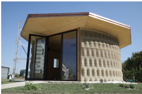
図 2. 建設地周辺の資材を用い、通気性の高い構造の土壁で作られた家「Gaia」
