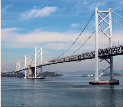
Fig.15: 瀬戸大橋 吊り橋の一例 [40]
