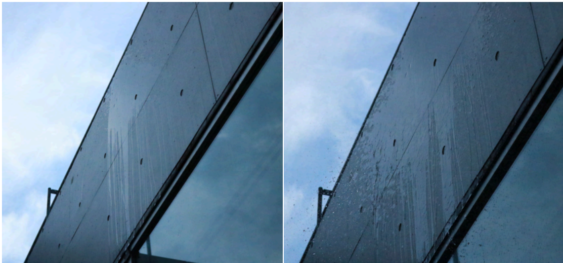
図 24: 水に濡れた打ち放しコンクリートの表情変化 (筆者撮影)
