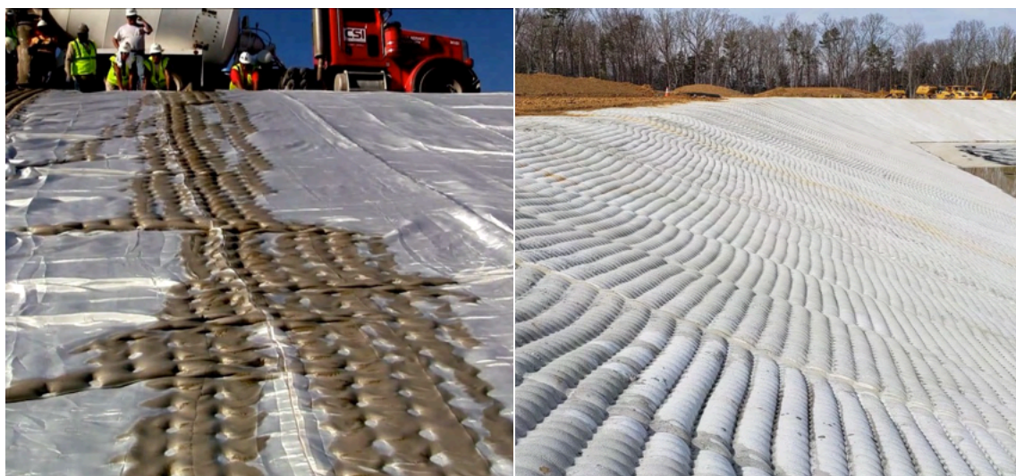
図 31: 急勾配の斜面でも施工が可能なファブリック型枠 ([32] より引用)
