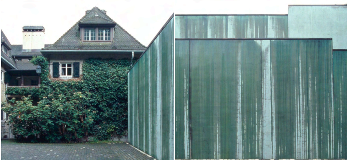
図 26: オスカー・ラインハルト美術館。増築においてコンクリートに銅を混入し、頻繁に濡れている部分に不規則な緑青の縞が現れるように仕掛けられている。
