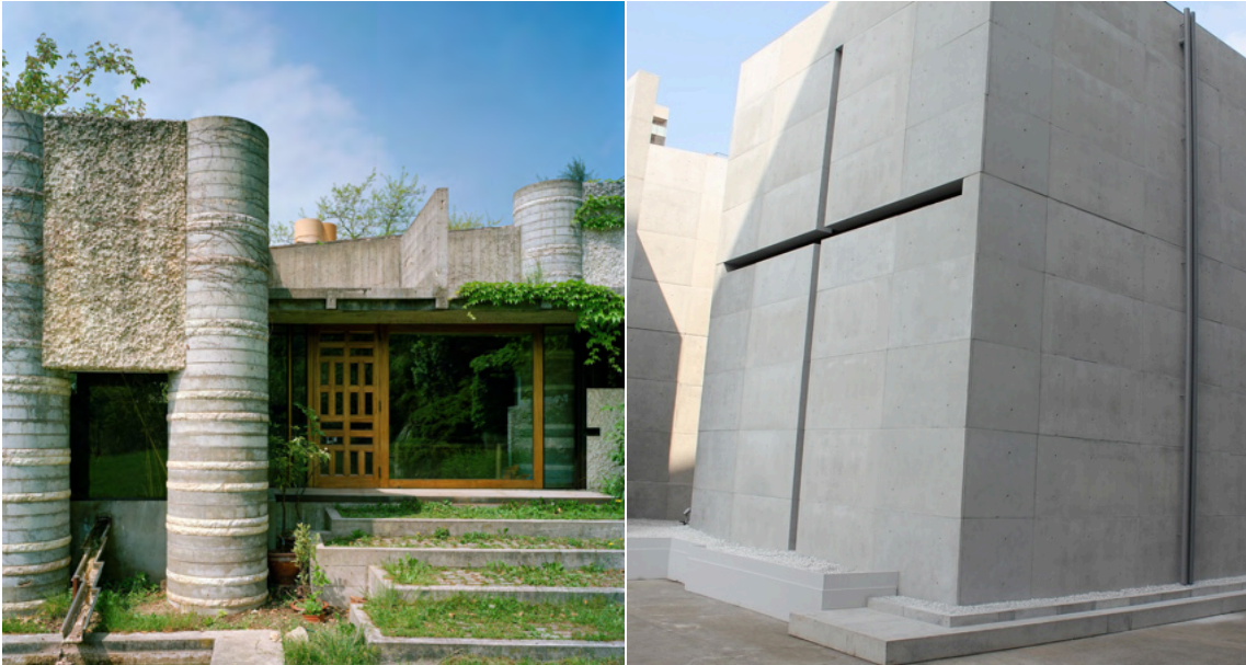
図 23: オトレンギ邸、バルドリーノ、ヴェローナ、1974-9 年、カルロ・スカルパ設計。石とコンクリートによる柱のディテール (左)。安藤忠雄、光の教会 (右)
