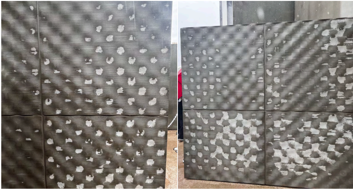
図 34: 雨の日の Cooling Panel (筆者撮影)
