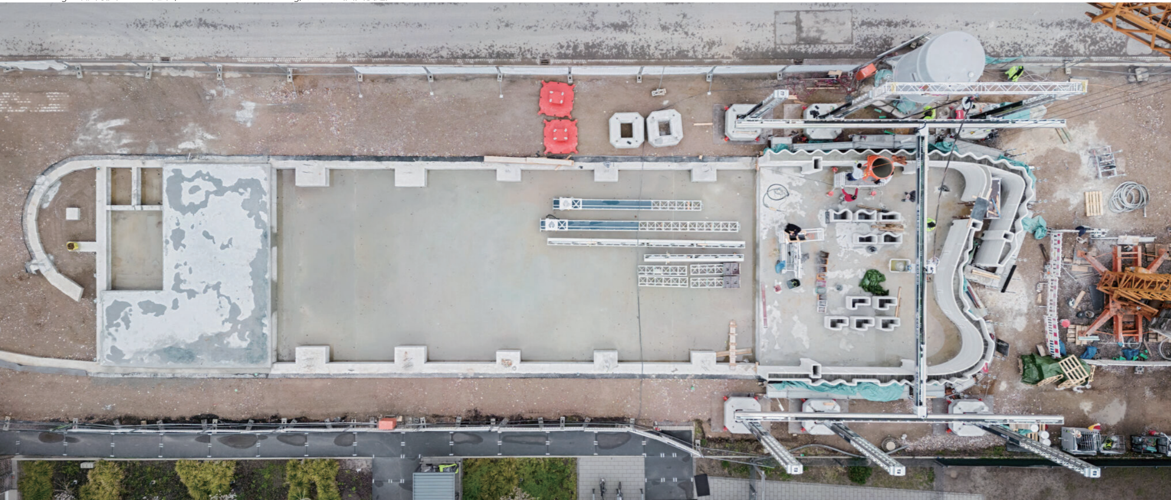
fig1. 欧州最大の 3DP 建築 ,WAVEHOUSE in Heidelberg, ドイツ（出典後述）
